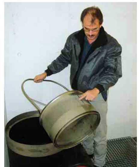
Regenwasserfilter, Entnahme Bild 10 des Filtereinsatzes zur Reinigung
