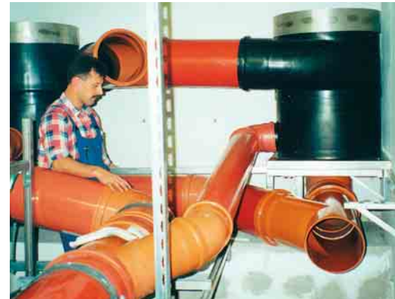
Montage Regenwasserfilter Bild 11 mit Anschlussleitungen für Zulauf (oben), Ablauf zum Regenspeicher (Mitte), Überlauf zur Spree (unten)
