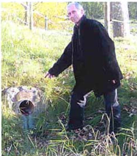
Architekt Dieter Haarnagell beim Regenwasserzulauf in die Versickerungsmulde.
